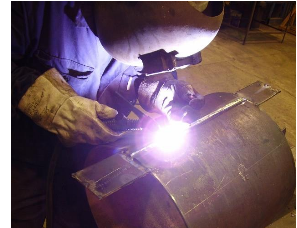
Soldadura Procedimientos homologados
